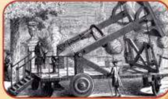
الشكل 1 تركب عدسات هذا الجهاز الحلاق ضوء الشمس، مما أنتج حرارة كافية لحرق الألباس.
