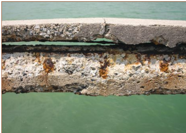
الشكل 11-2 الأضرار بالخرسانة بفعل البلّورات الملحية.
