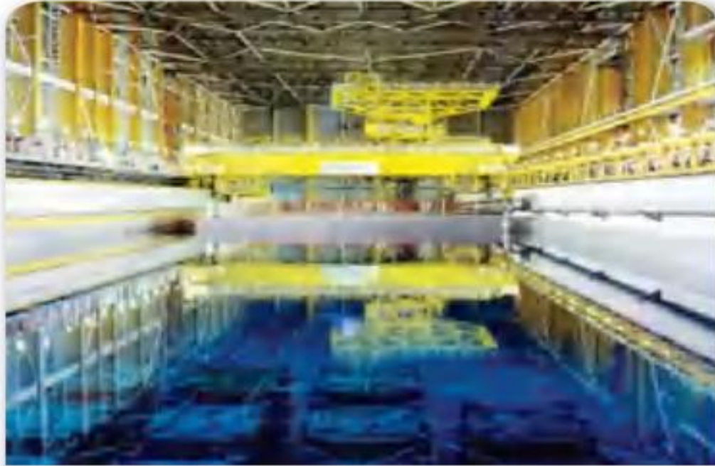
■ الشكل 16 يُخزّن الوقود المستنفد في حاويات مانعة للتسرب في محطات توليد الطاقة النووية ويُغمر غالبًا في برك مُصممة خصيصًا لهذا الغرض.
