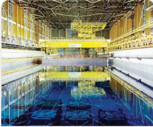
■ الشكل 16 يُخزّن الوقود المستنفذ في حاويات مانعة للتسرب في محطات توليد الطاقة النووية ويُغمر غالبًا في برك مُصممة خصيصًا لهذا الغرض.
