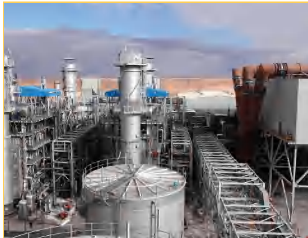
إنشاء محطات للكهرباء في اليمن
