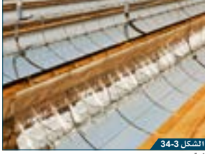
الشكل 34-3 تُركّز المرايا الكروية ضوء الشمس على أنابيب لتسخين الماء في محطة الطاقة الشمسية.
