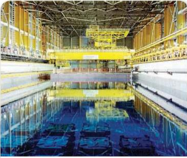
■ الشكل 16 يُخزّن الوقود المستنفد في حاويات مانعة للتسرب في محطات توليد الطاقة النووية ويُغمر غالبًا في برك مُصممة خصيصًا لهذا الغرض.
