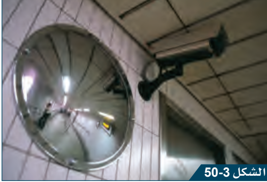
الشكل 3-50 تُستخدم المرآة المُحدّبة كمرآة مراقبة أمنية في محطات مترو الأنفاق.
