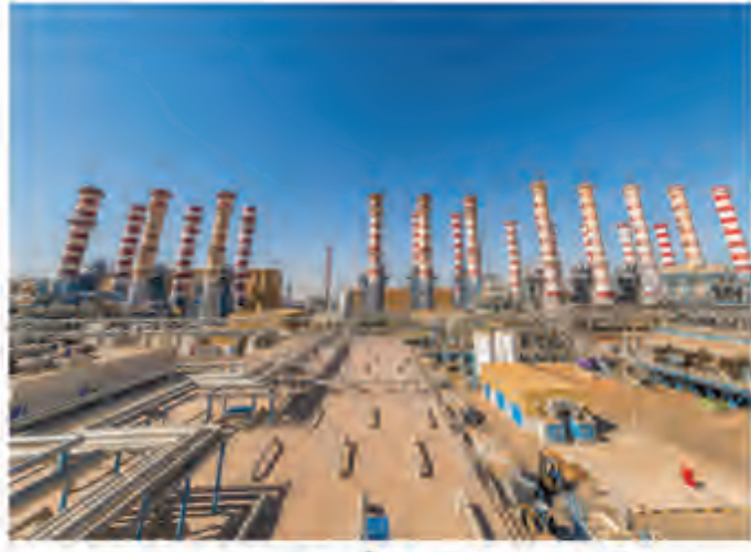
محطة تحلية مياه البحر - رأس فنتاس - قطر
