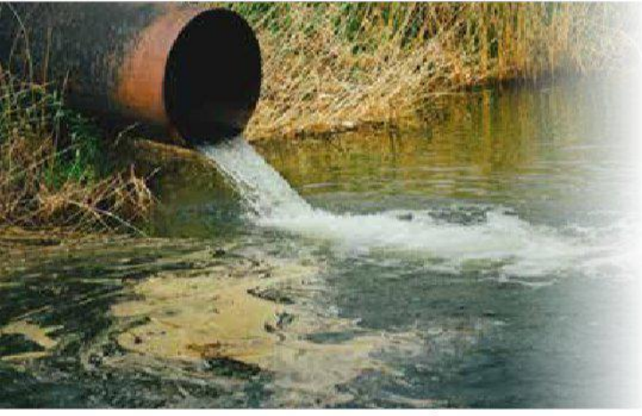
الشكل (6): مياه الصرف الصحي.
