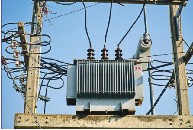
الشكل 31-5 محوّل جهد عالي للتيار المتردد.
