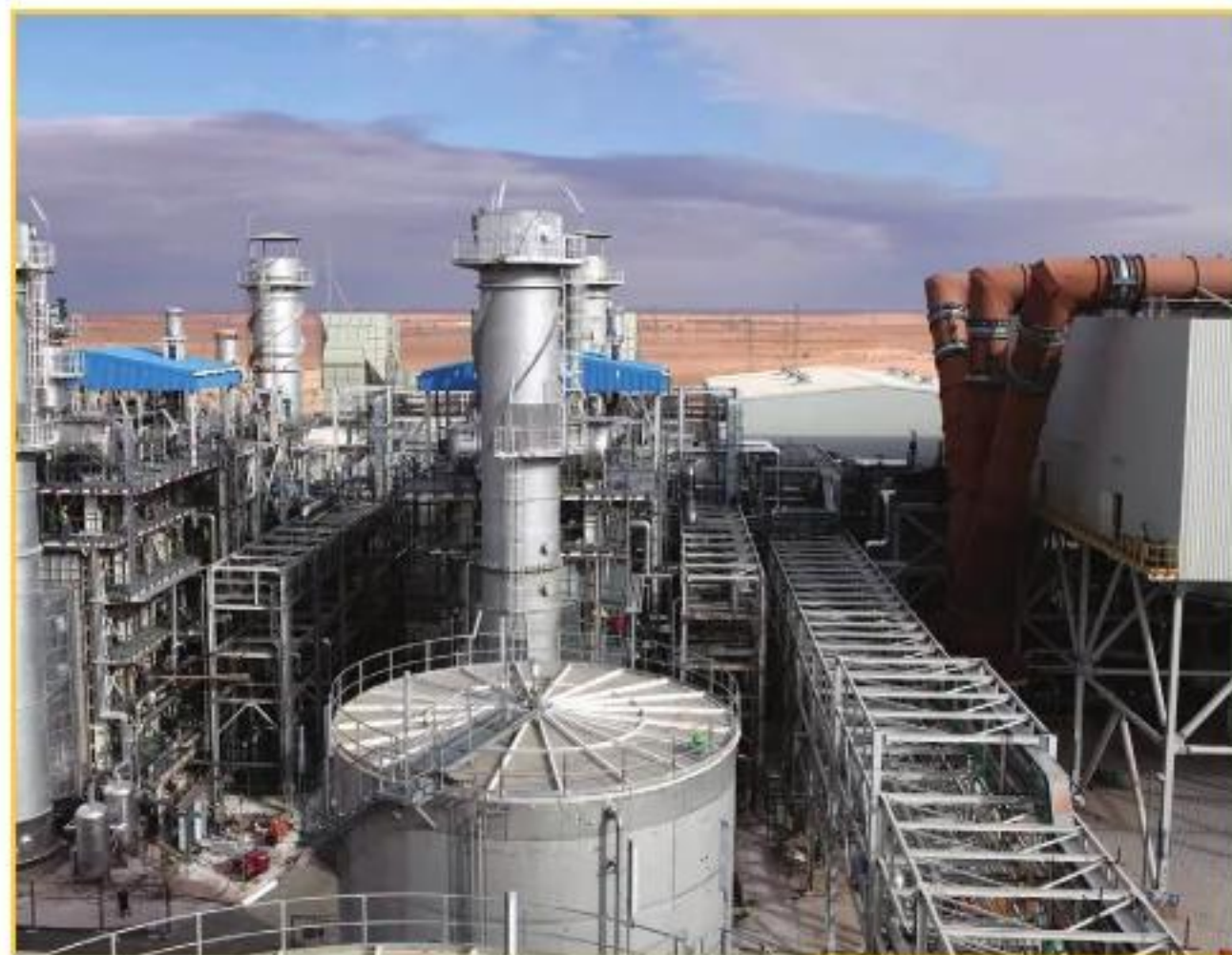
إنشاء محطات للكهرباء في اليمن
