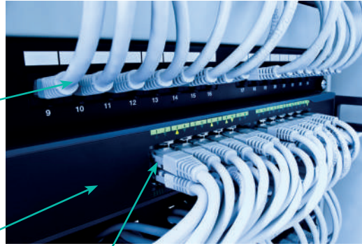
الشكل 4.14 خزانة الشبكة مع لوحة التجميع. ما فائدة استخدام لوحة التجميع؟
