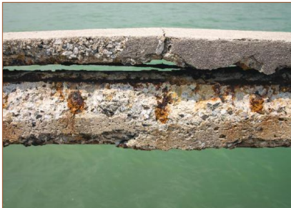
الشكل 11-2 الأضرار بالخرسانة بفعل البلّورات الملحية.
