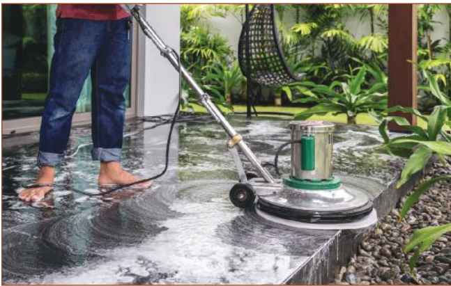
الشكل 2-15 تلميع سطح الحجارة لمنع تجوية تجمّد المياه.
