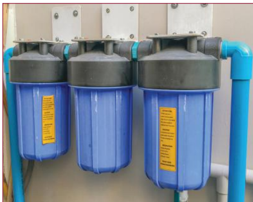
الشكل 4-4 النظام المستخدم في العديد من المنازل لتنقية الماء.
