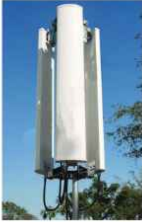
الشكل (43): الهوائي القطاعي.
