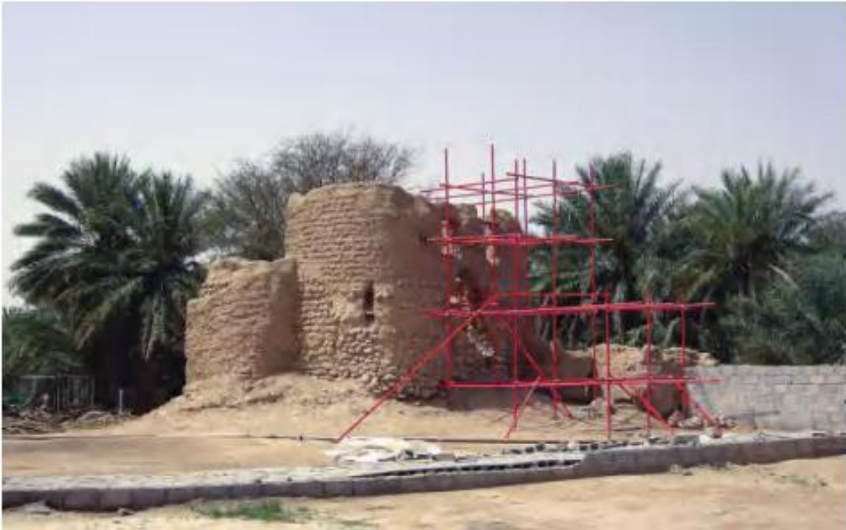
بيت حميد بن حضيبة الدرمكي أثناء عملية الترميم
