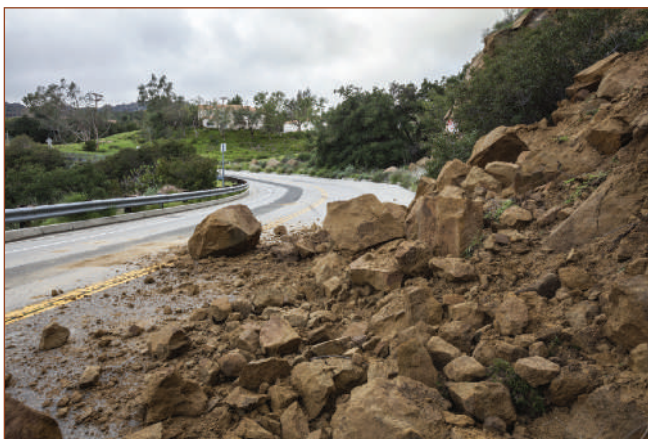
الشكل 2-29 طريق مغلق بسبب الانهيارات الأرضية.
