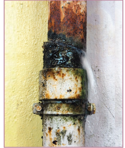
الشكل (20): طبقة من الصدأ المتكونة على أنبوب تصريف المياه العادمة.
