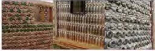
استخدام العبوات البلاستيكية كمادة بناء
