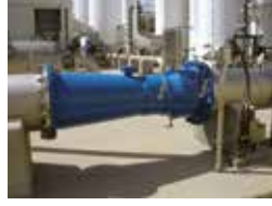
الشكل (33): مقياس فنتوري في إحدى محطات المياه.
