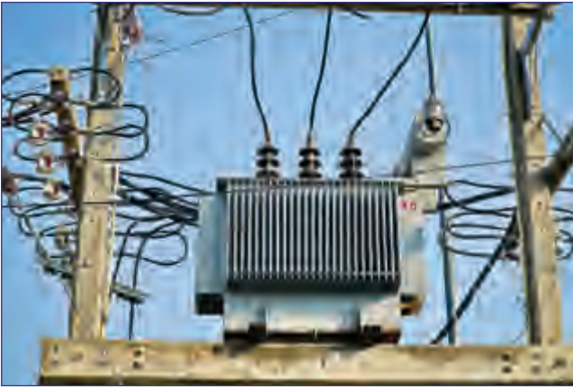
الشكل 31-5 محول جهد عالي للتيار المتردد.
