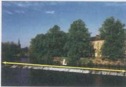
16. الأدوات يُستخدم السياج لقياس تدفق الماء في قناة. بالنسبة لسياج عريض مستطيل له غطاء علوي، يرتبط التدفق  $Q$  بالمتر المكعب في الثانية بطول السياج  $L$  بالأمتار والارتفاع  $H$  للماء بـ  $Q = 1.6LH^{\frac{3}{2}}$ . جد ارتفاع الماء على سياج يبلغ طوله 3 m وتدفقه  $38.4 \text{ m}^3/\text{sec}$ .
