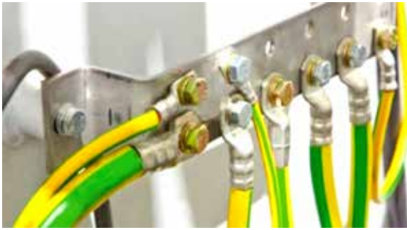
الشكل (8): تجميع أسلاك التأريض.
