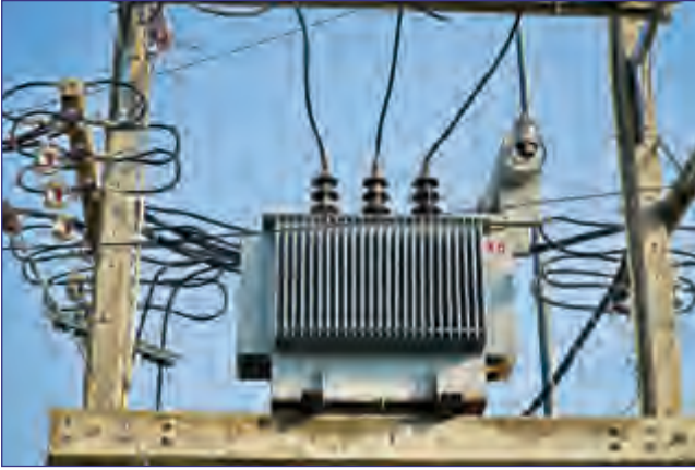
الشكل 31-5 محوّل جهد عالي للتيار المتردد.
