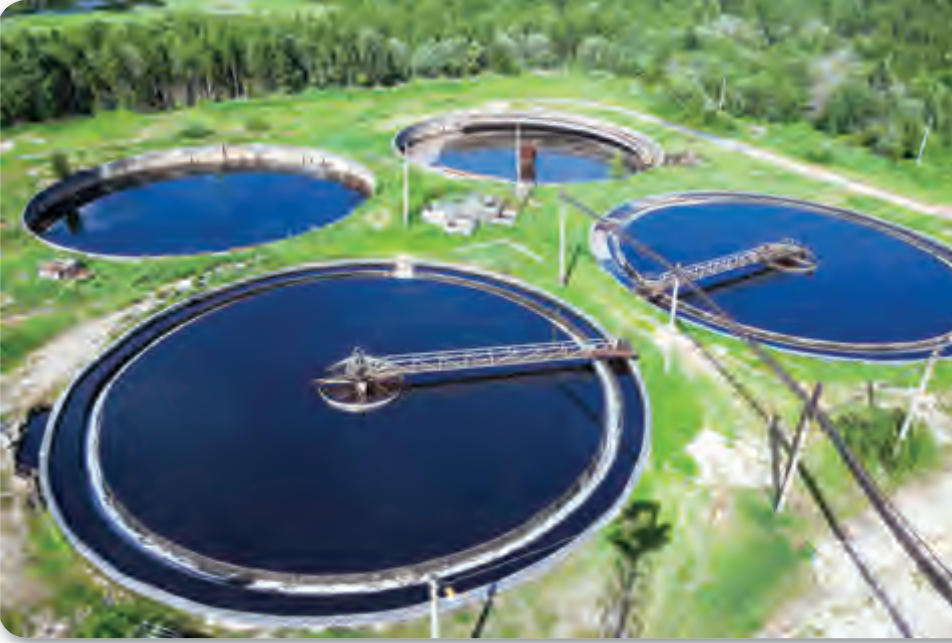
الشكل 16-7 يتم ضمن مراحل تنقية مياه الشرب التخلص من الرسوبيات بإدخالها إلى أحواض ضخمة لترسيبها.
