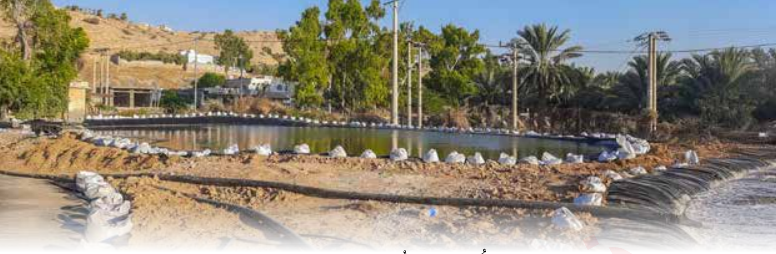
الشكل (15): محطة تنقية مياه الصرف الصحي.
