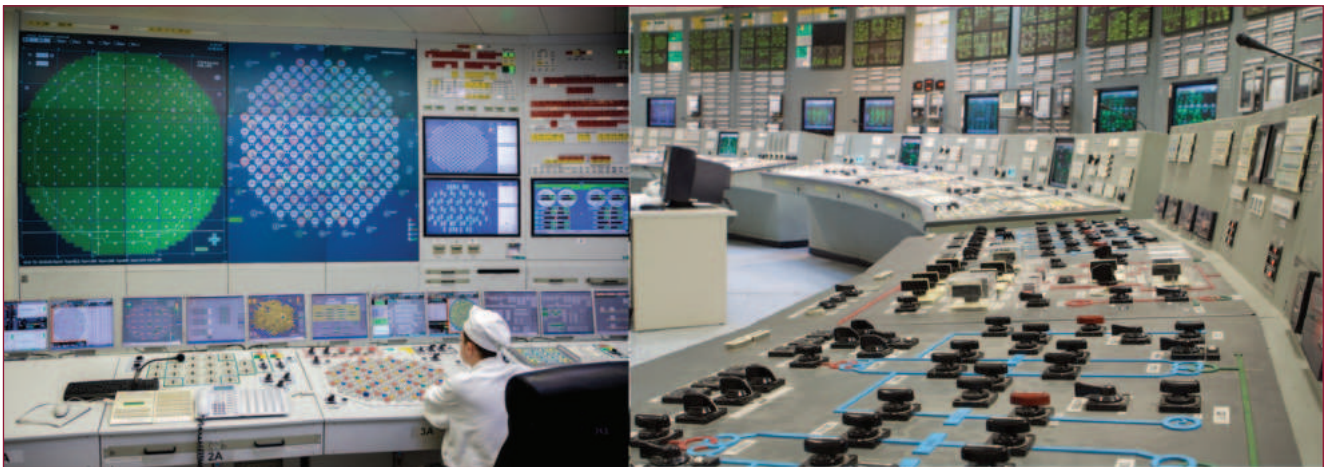
الشكل 9-8 غرفة تحكم لمفاعل انشطار نووي مع شاشات تعرض حزمة الوقود ومواضع قضبان التحكم.
