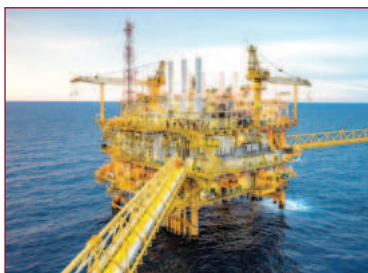
الشكل 8-20 منصة حفر.
