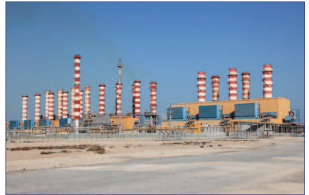
الشكل 5-19 محطة طاقة كهربائية.
